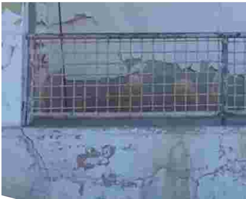
Vivienda “AE 003”, edificación en estado de conservación bueno, aislada, de un nivel con un volumen sobresaliente en pasillo de acceso. Su estructura no presenta daños visibles, Su cubierta se encuentra en buen estado, sus vanos de ventanas están protegidos por rejillas, la pintura de muro se observa con desprendimientos y presenta humedad en la parte inferior de la fachada.
